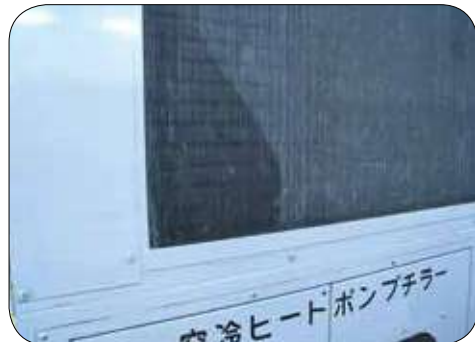
熱交換器の油のにじみ
