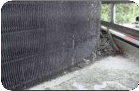
熱交換器下部の腐食
