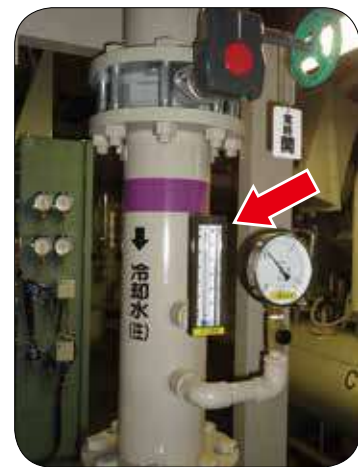
写真-E 冷却水入口温度
