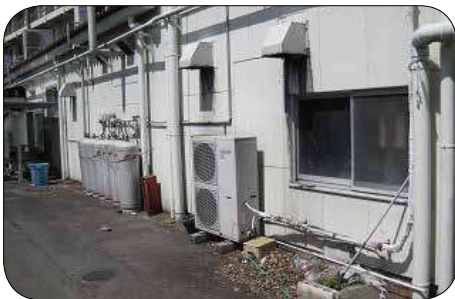
室外環境異常による配管の劣化
