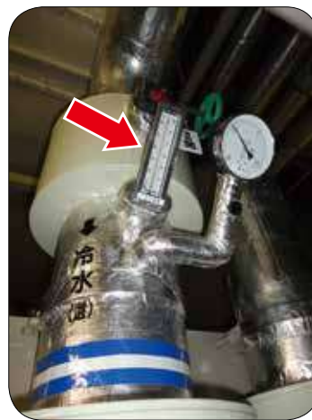
写真-D 冷水入口温度
