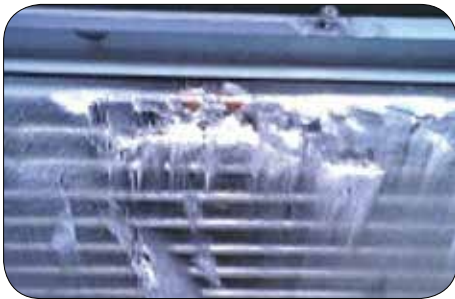
熱交換器表面の損傷
